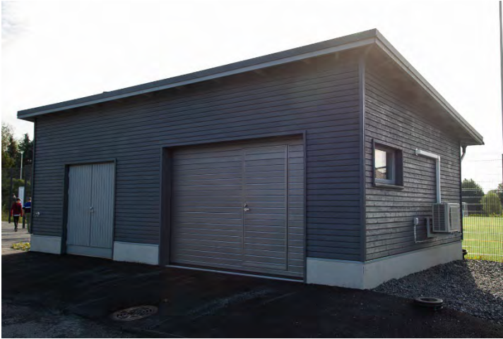
Yhtenäiskoulun varistorakennus urheilukentän laidalla. Valmistunut 2020, kerrosala 45 kem 2 . Kuva: Helena Väisänen
