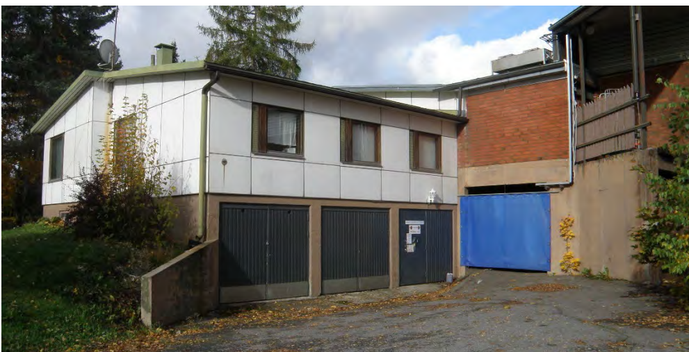
Urjalantie 35 asuin- ja liikerakennus pihan puolelta. Kuva: Urjalan kunta.
