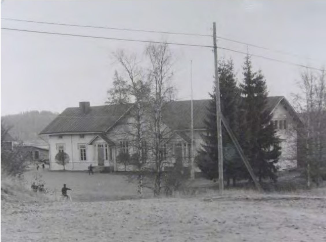
Lastenkoti, joka toimi vuosina 1924-1976 kansakouluna (rak. 1888, purettu 2008). Kuva: Urjalan kunta.
